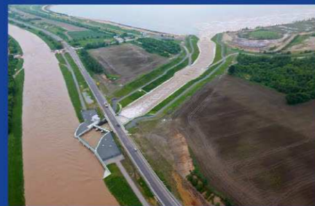
Hochwasserentlastungsanlage während der Flut Anfang Juni 2013.
