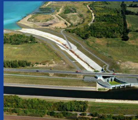
Hochwasserentlastungsanlage bei Zitzschen nach Fertigstellung.
