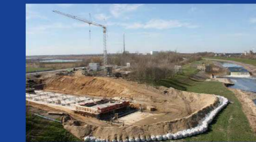
Betriebsauslass im Bau, rechts die Weiße Elster mit der Gefällestufe Hartmannsdorf entgegen der Fließrichtung.
