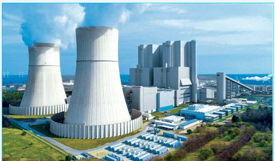
Abb. Die BigBattery Lausitz im Vordergrund des Braunkohlekraftwerks Schwarze Pumpe befindet sich seit Ende 2020 im Dauerbetrieb Bild: Andreas Franke/LEAG
