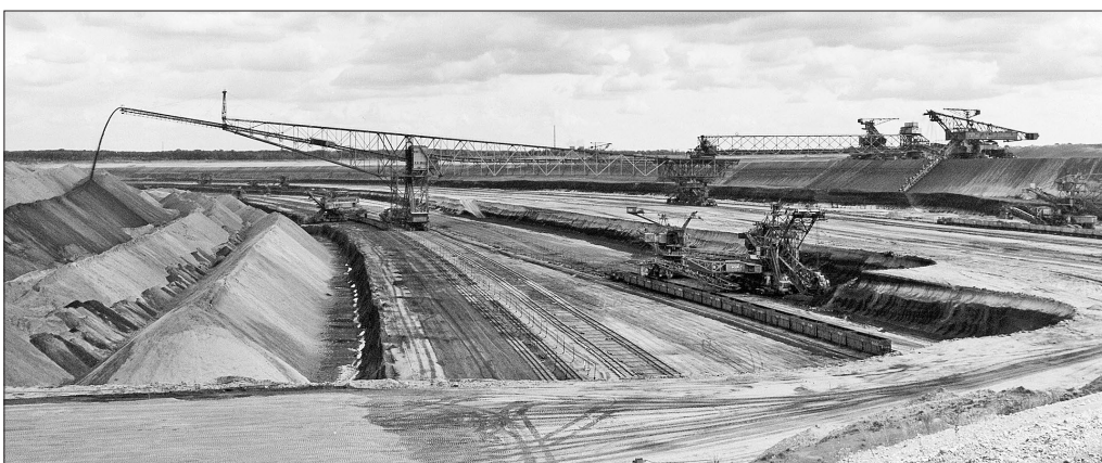
Abb. 1: Abraumförderbrücke AFB 18, 1939 bis 1999 Tagebau Zwenkau (Quelle: LMBV, Foto: Peter Radke)
